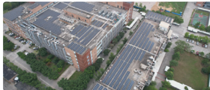
太陽能板發電系統建置 (東莞飛宏 - PHCJ 廠)
